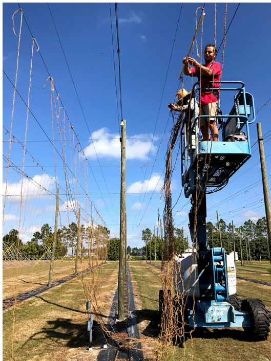
Figura 3. Instalando cuerdas en un Sistema de tutorado usando un elevador.
