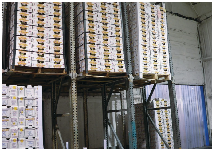
Cuartos de almacenamiento refrigerados en las instalaciones y facilidades de un centro de recepción de mangos
