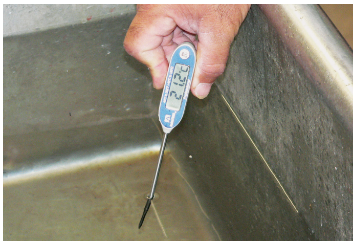
Medición de la temperature del agua en el hidrogenfriador
