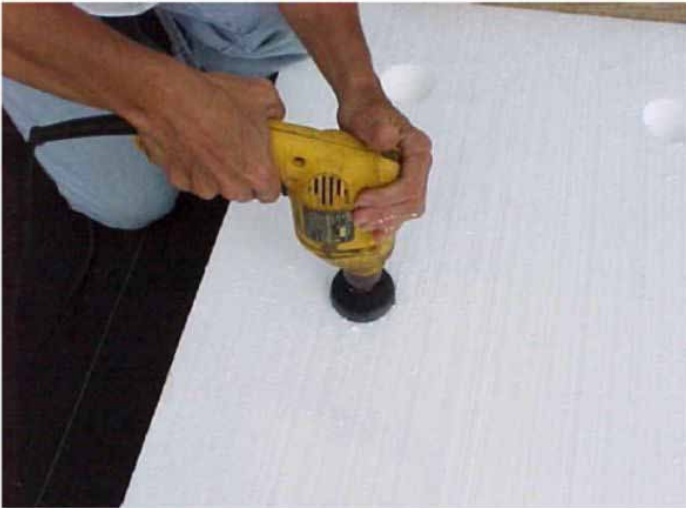
Figure 4. Taladrando huecos en la plancha de poliestireno para colocar los transplantes.
