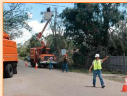
Fije una banderola o use barricadas y señales de advertencia para controlar el tráfico y los curiosos.
