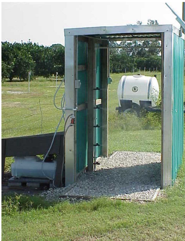
Figure 13. Estación de descontaminación.
